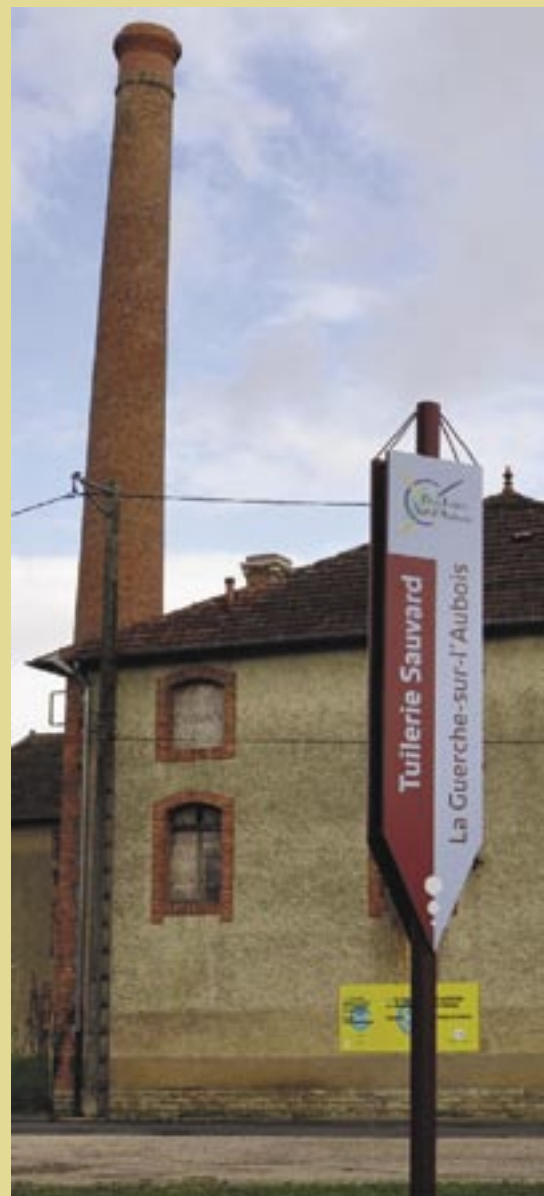
Le nouveau panneau devant l'usine
