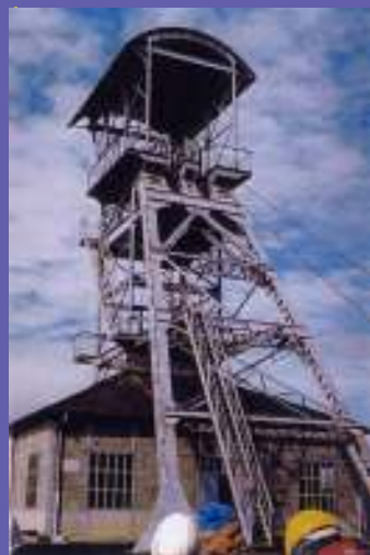
le chevalement du puits des Glénons
