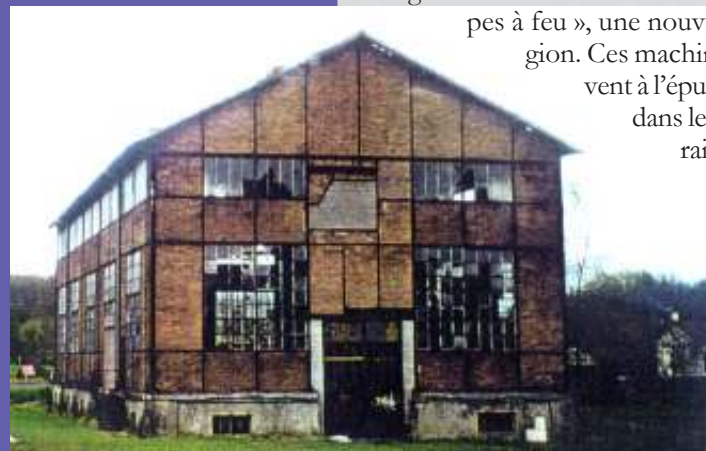
halle en brique et fer au Puits Henri Paul
